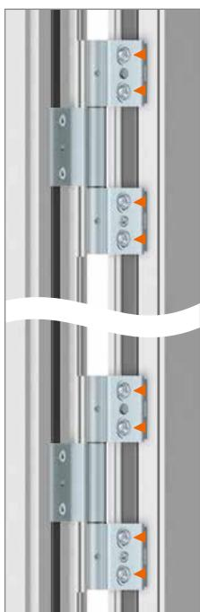
Alle rahmenseitigen Befestigungsschrauben leicht lösen.
